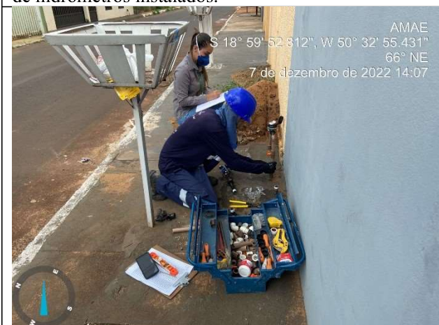
Autor: AMAE Descrição: Equipe da AMAE acompanhando a instalação de hidrômetros pela empresa Novaes Engenharia
