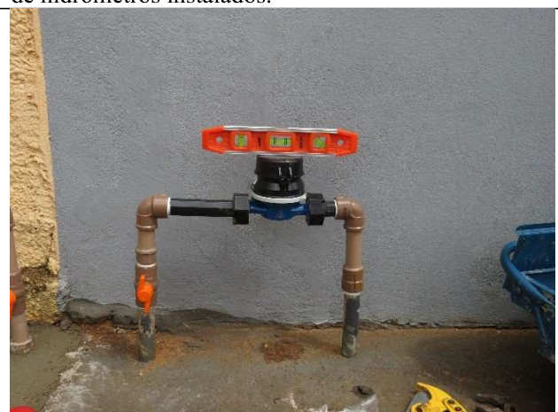
Autor: AMAE Descrição: Nivelamento de hidrômetro.
