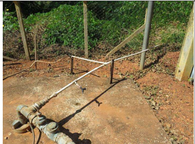
Autor: AMAE Descrição: Identificação de poço com derivação.
