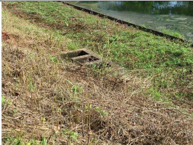
Autor: AMAE Descrição: Caixas de contato do esgoto na entrada das lagoas facultativas
