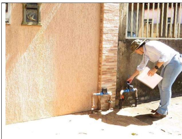
Autor: AMAE Descrição: Verificação da hidrometração.
